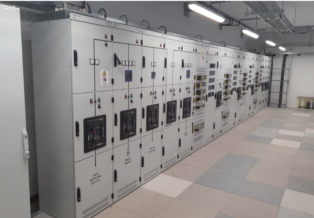
Neubau der Kinderklinik Freiburg: Der Aufbau der Energieversorgung (li.) sowie der Kommunikations- und Datentechnik (re.) war herausfordernd.
